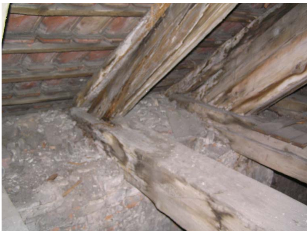
Foto 10: Pohled na část krovu na východní straně, v těchto místech je dřevo silně degradováno biologickými činiteli, v minulosti do těchto míst zatékalo, dřevní hmota se rozpadá – (viz detaily na dalších foto)
