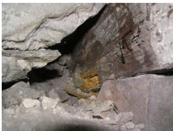
Foto 36: Strop nad 1. patrem, trám, místo odběru vzorku dřeva č. 17
