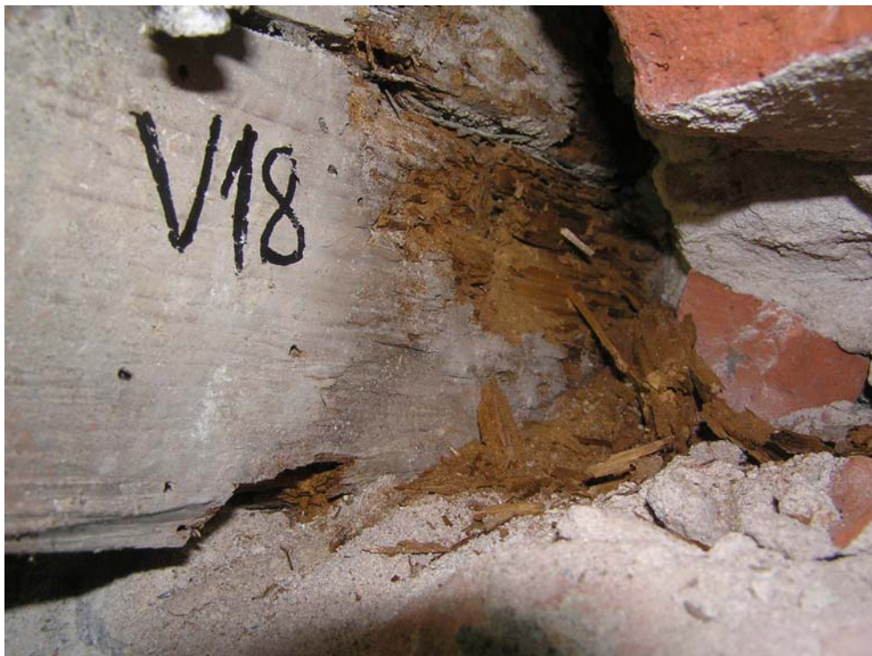
Foto 34: Strop nad 1. patrem, silná degradace dřeva v oblasti zhlaví trámu (stropní konstrukce v oblasti severozápadního nároží)
