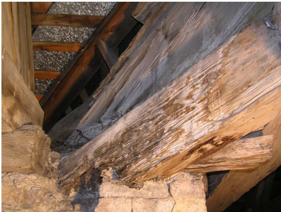
Foto 15: Část krovu na jihozápadní straně, v těchto místech je dřevo silně degradováno biologickými činiteli, dřevní hmota se rozpadá
