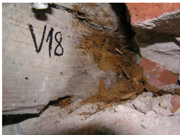
Foto 37: Strop nad 1. patrem, trám, místo odběru vzorku dřeva č. 18
