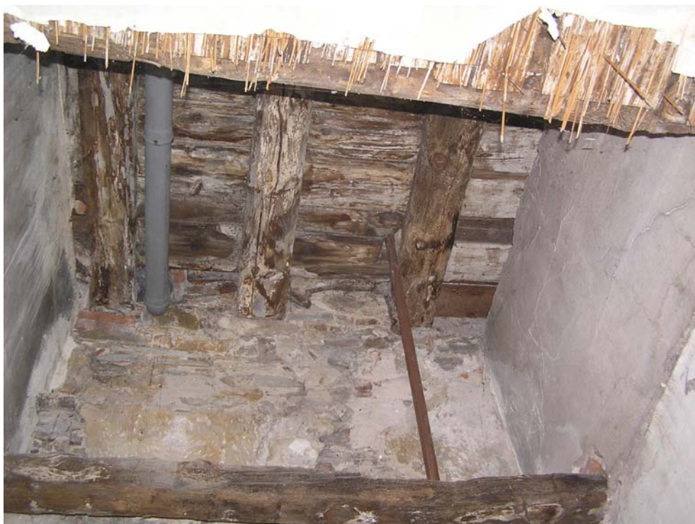
Foto 31: Strop nad 1. patrem, část stropní konstrukce, stav této části lze charakterizovat jako havarijní (detail viz foto 33)
