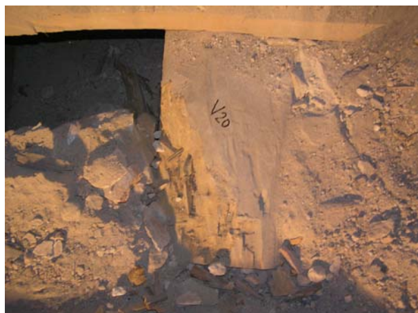
Foto 39: Strop nad 2. patrem, trám, místo odběru vzorku dřeva č. 20
