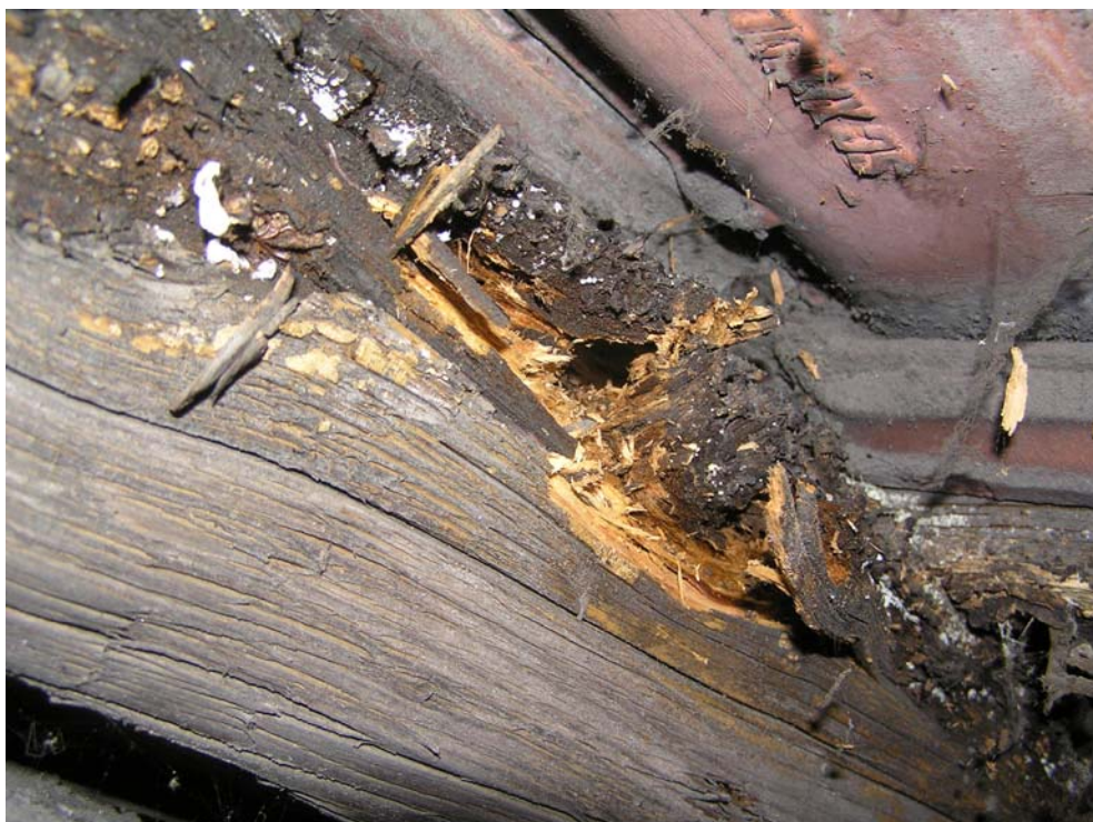
Foto 12: Detail z foto 10, krokev, dřevo je silně degradováno voštinovou hnilobou
