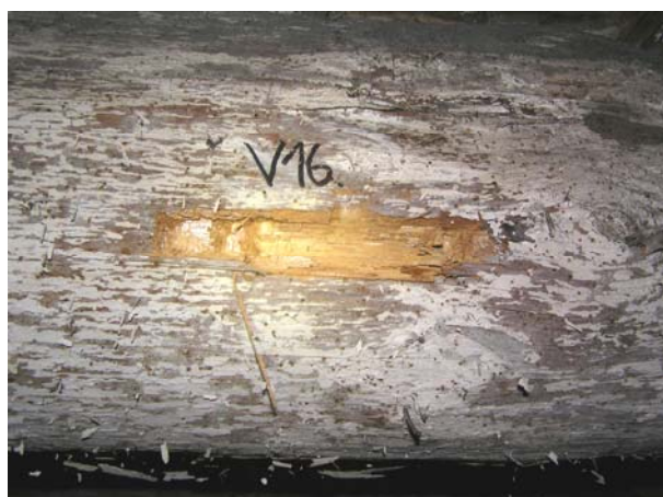
Foto 35: Strop nad 1. patrem, trám, místo odběru vzorku dřeva č. 16
