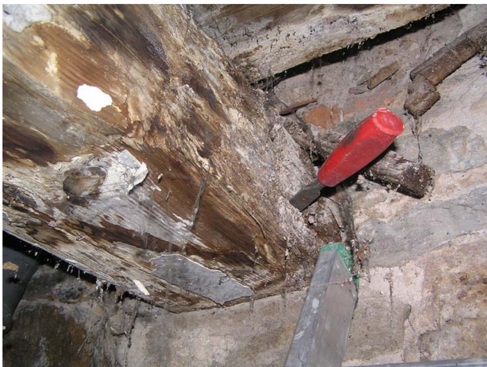
Foto 33: Strop nad 1. patrem, (detail z předchozích foto), silná degradace dřeva v oblasti zhlaví trámu
