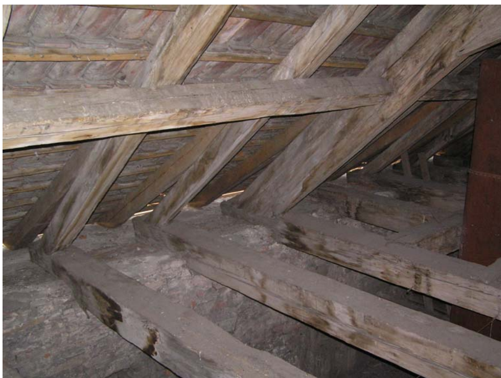
Foto 14: Pohled na část krovu na západní straně, v těchto místech je dřevo degradováno biologickými činiteli, v minulosti do těchto míst zatékalo
