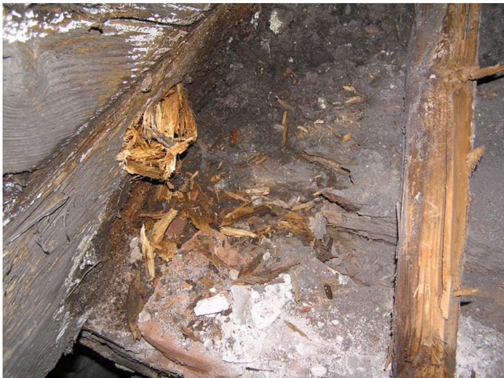
Foto 11: Detail z foto 10, styk vazný trám – pozednice – krokev, dřevo je silně degradováno voštinovou hnilobou
