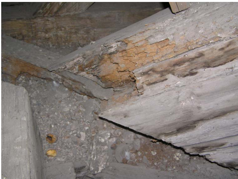
Foto 16: Část krovu na jihozápadní straně, v těchto místech je dřevo silně degradováno biologickými činiteli, dřevní hmota se rozpadá
