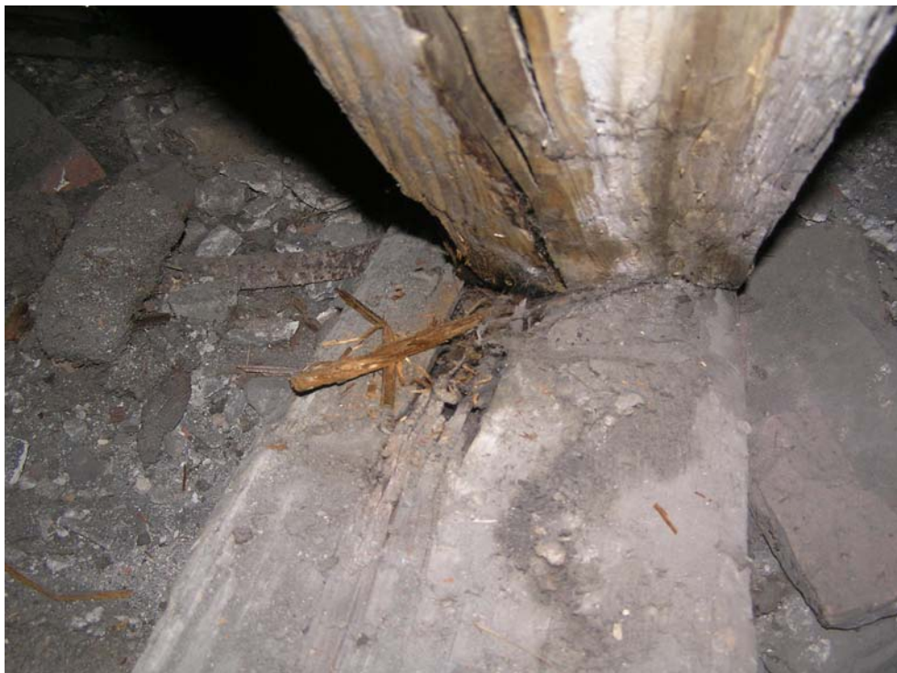
Foto 13: Detail z foto 10, styk vazný trám – krokev, dřevo je silně degradováno voštinovou hnilobou
